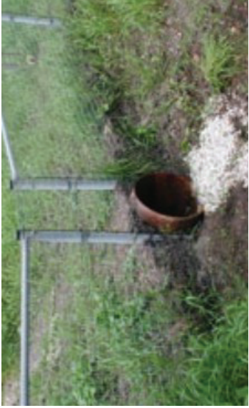
Aansluiting van het raster op de dassentunnel (Bron: Kennisdocument Das Bij12)
